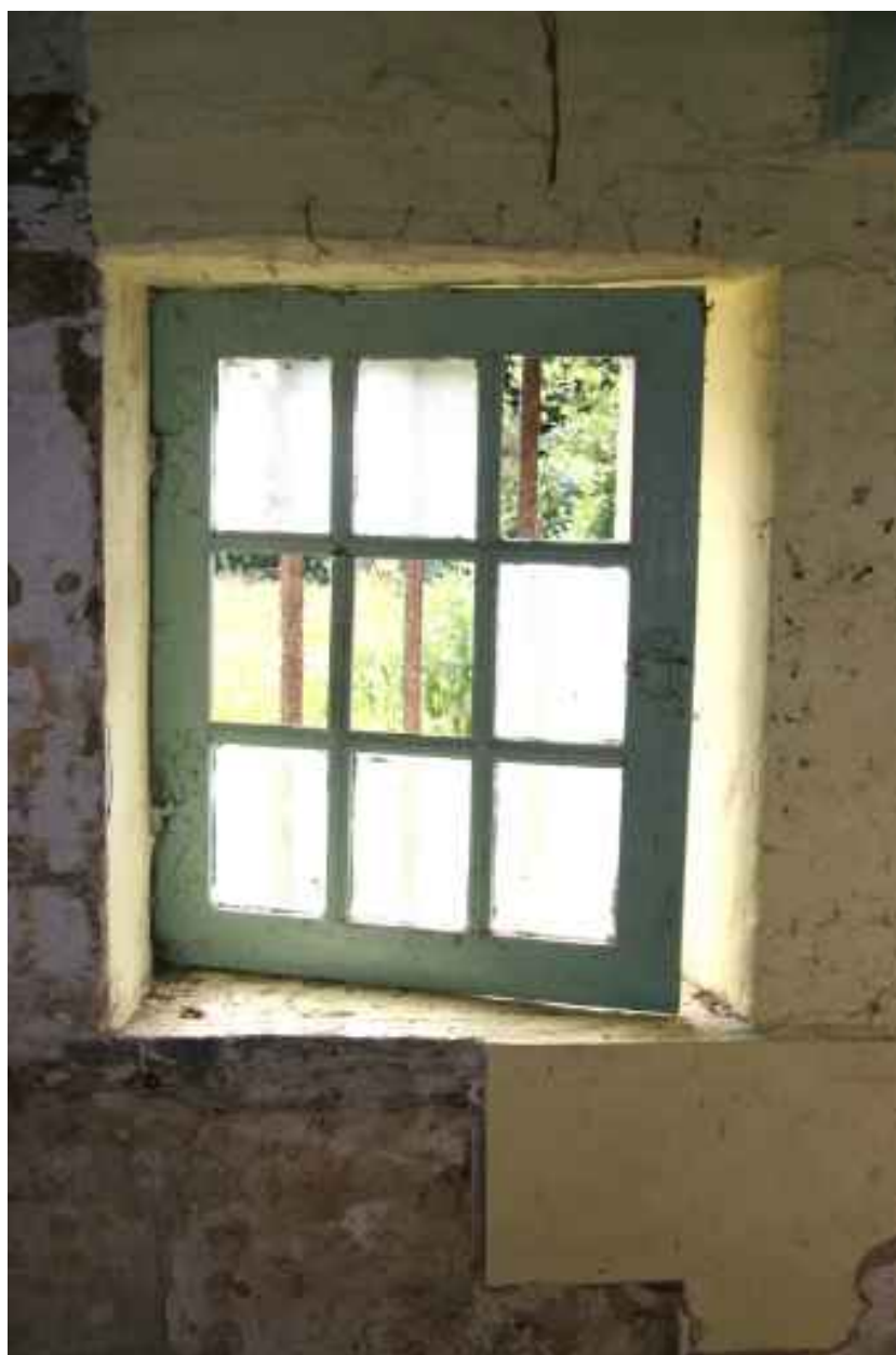
La chambre à feu : menuiserie de la baie.
