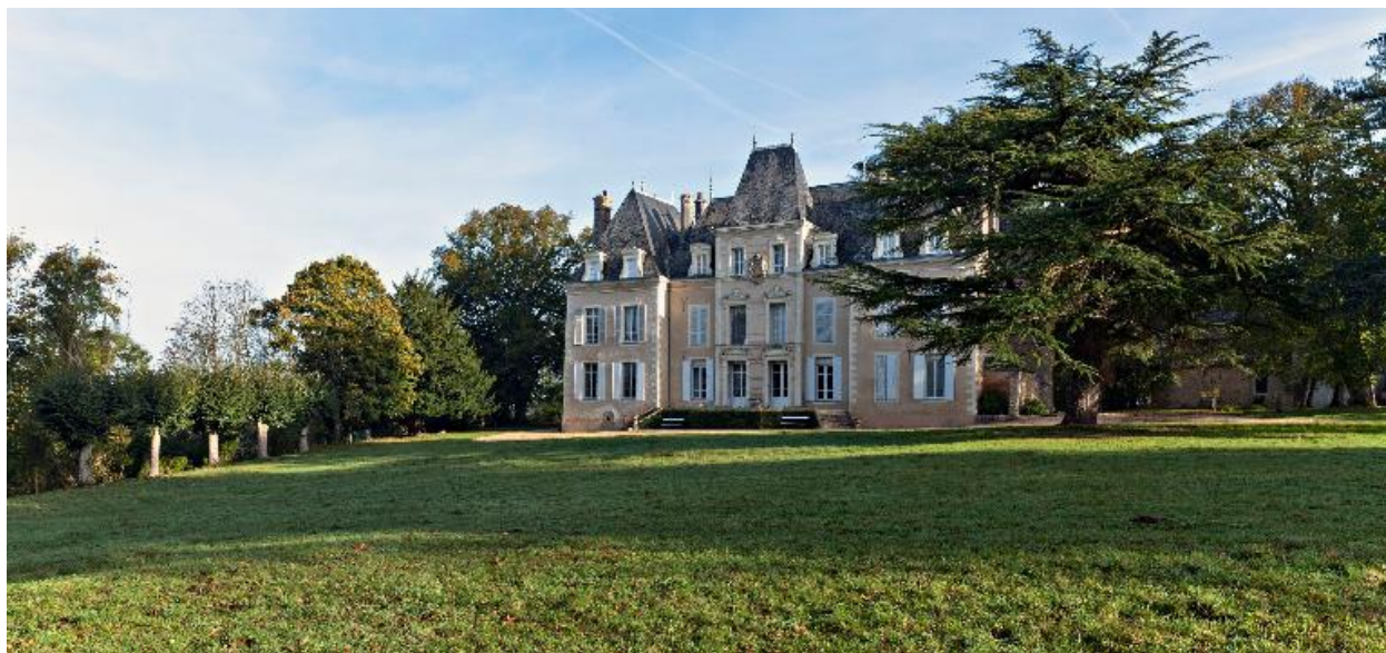
Vue d'ensemble du jardin et du château depuis le sud-ouest : l'élévation postérieure.
