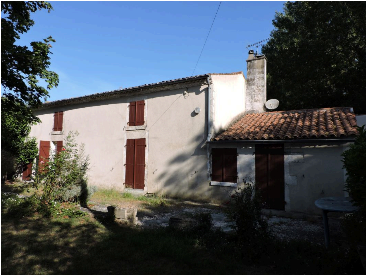
Le logis vu depuis le sud-est.
