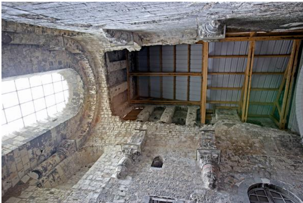
Eglise : bras sud du transept : vue en contre-plongée vers les vestiges de voûte et l'arcature intérieure du clocher.
