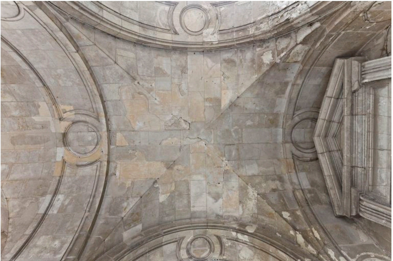
Le portique de la face occidentale, détail : voûte d'arête plate.
