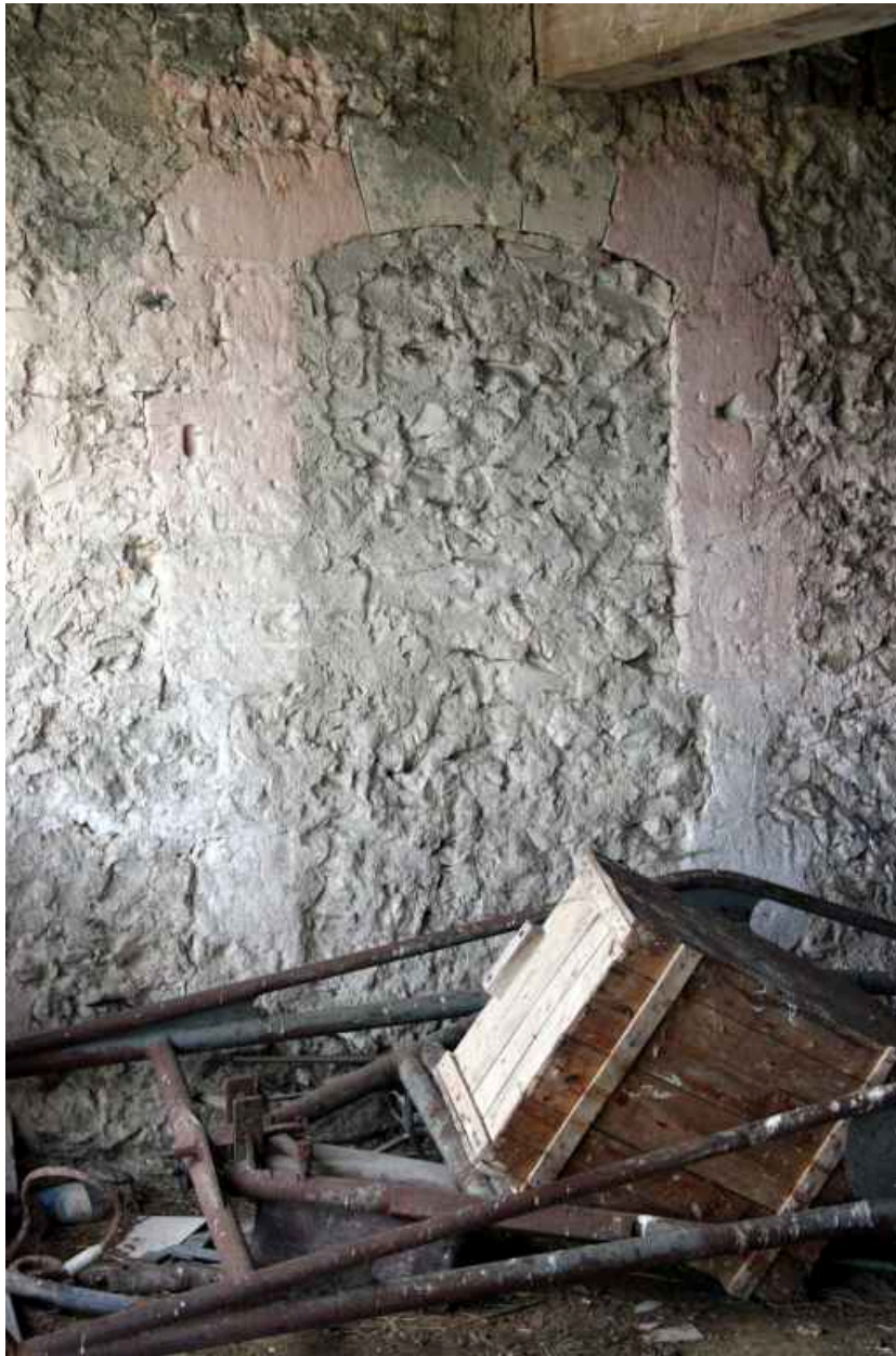
Façade postérieure : porte.
