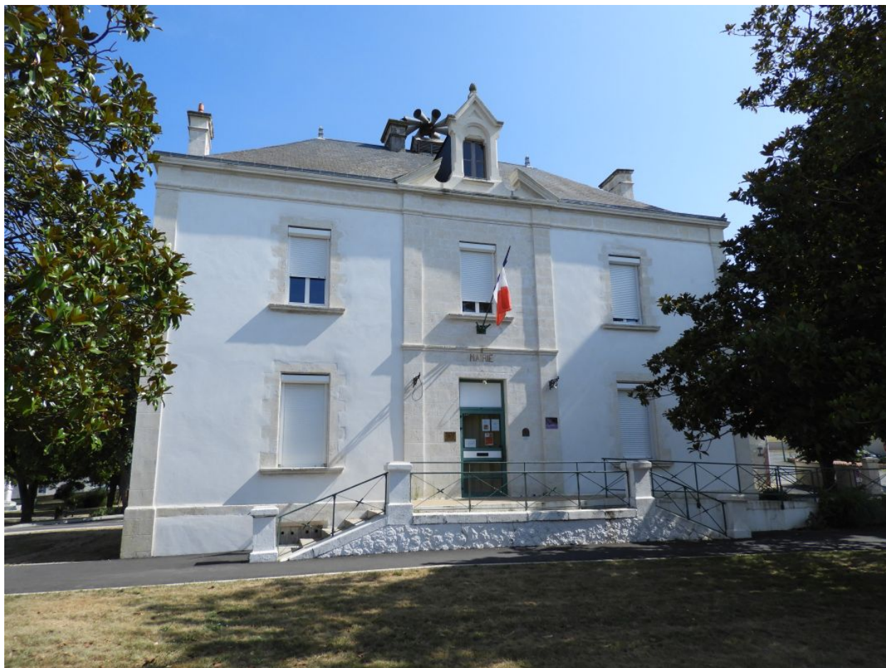
La mairie vue depuis le sud, façade principale.
