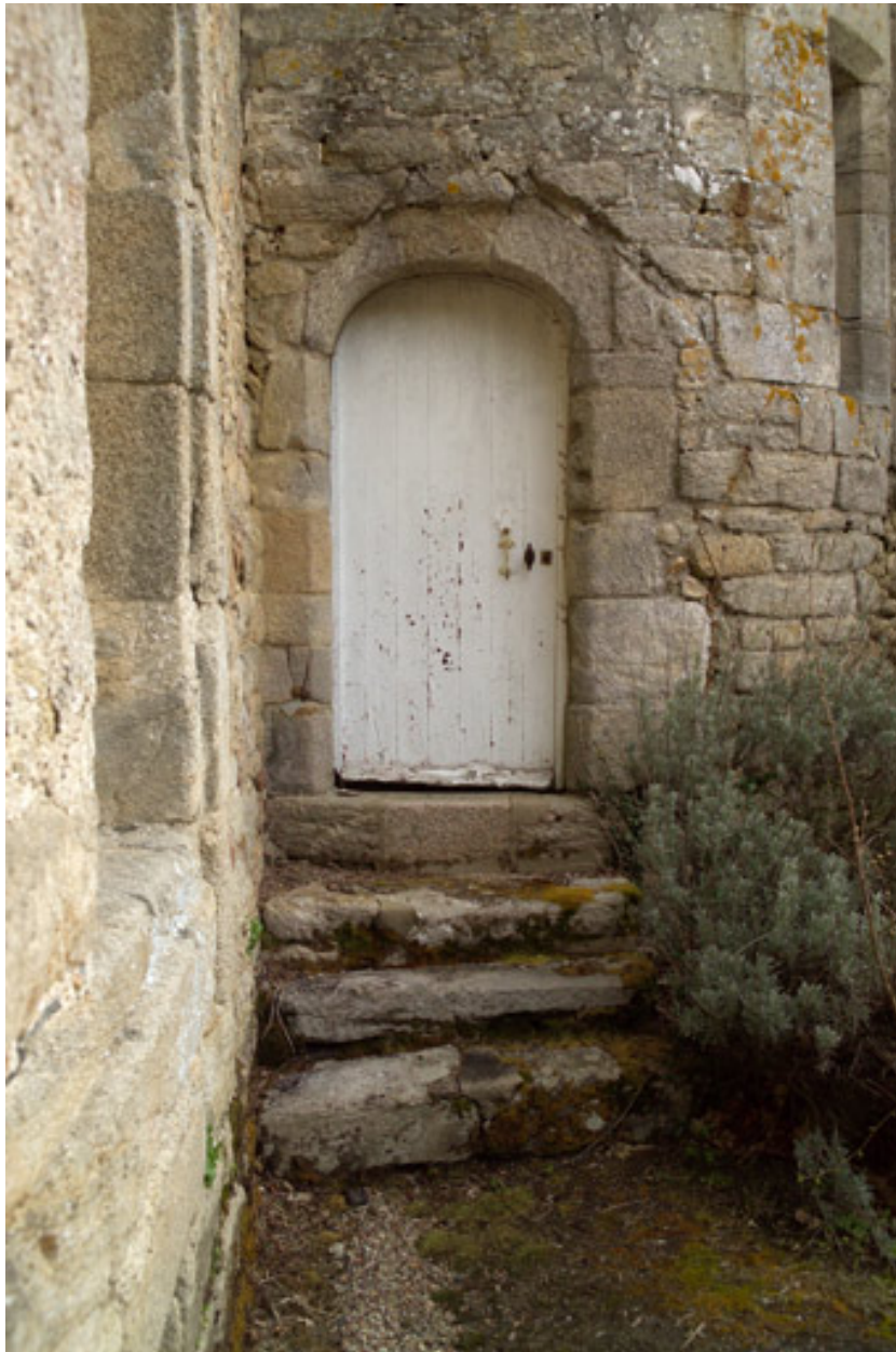
Porte donnant accès à l'escalier du cabinet.
