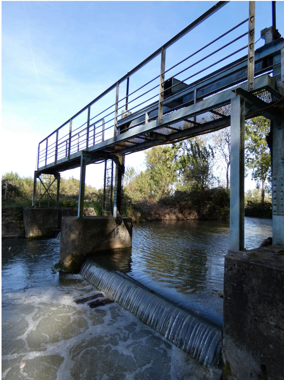
Le barrage et son portique vus depuis le sud, rive gauche.
