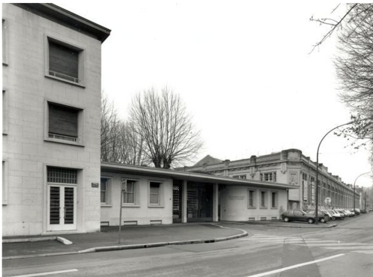
Actuelle porterie : élévation sur le boulevard du Ronceray.
