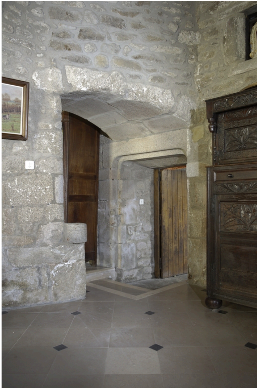
Logis. Aile est. Cuisine. Vue des portes ouvrant sur la salle et sur la cave.
