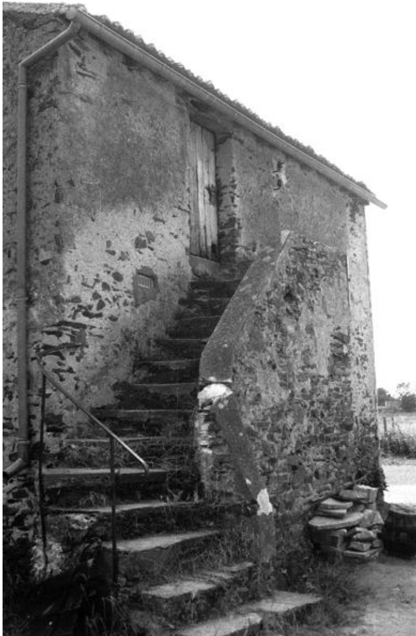
La Barbonnière. Détail de l'escalier permettant l'accès au grenier.
