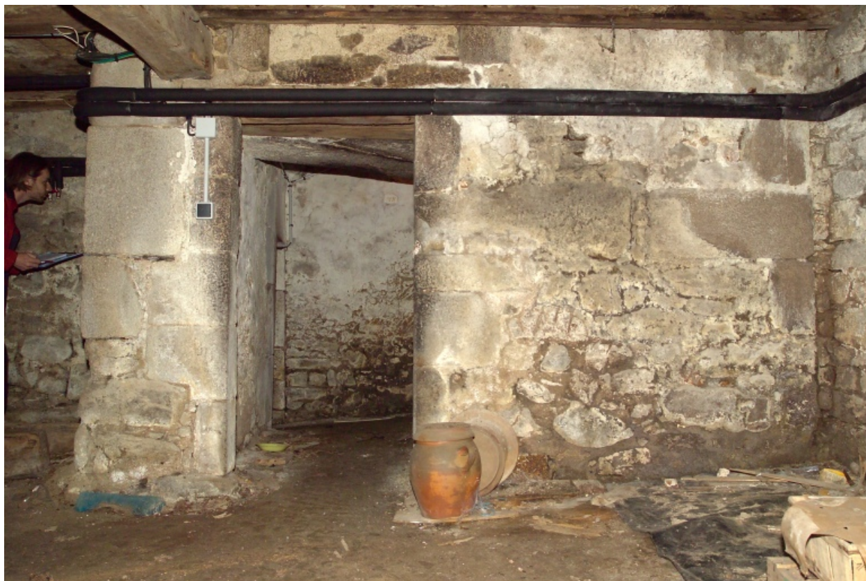
Vue depuis la cave du parement de la tour d'escalier.
