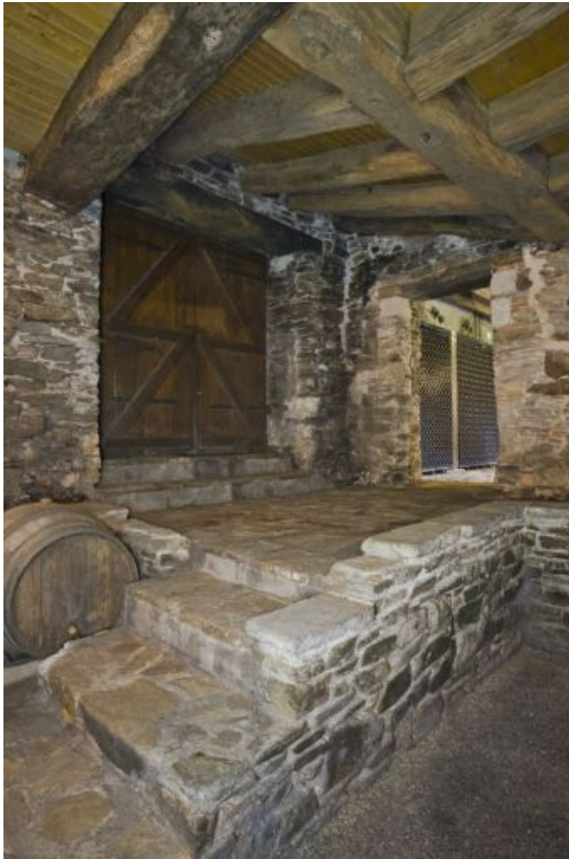
L'aile nord : accès au chai et détail de la poutraison.
