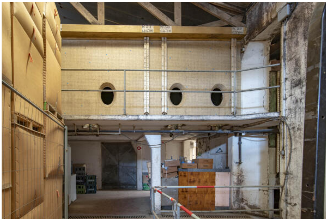
Cuves aériennes sur pilotis.
