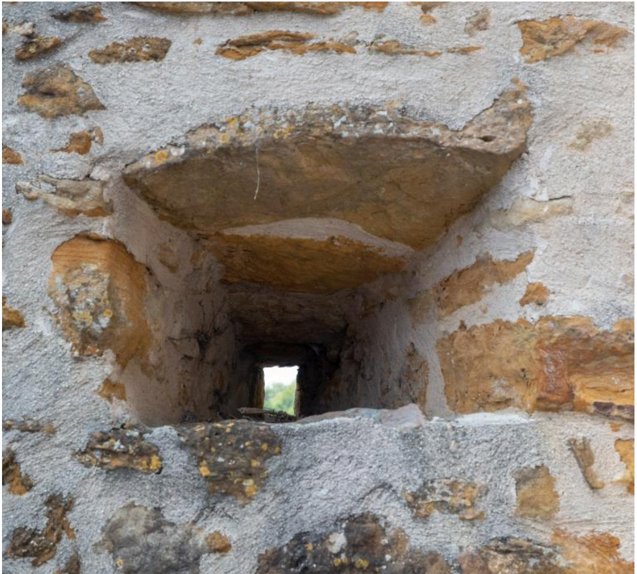
L'ouverture dans la maçonnerie.
