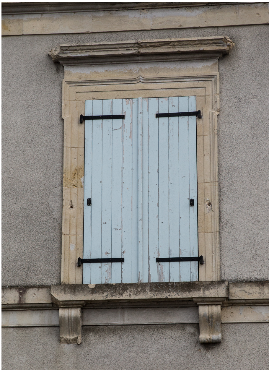
Une fenêtre de l'étage.
