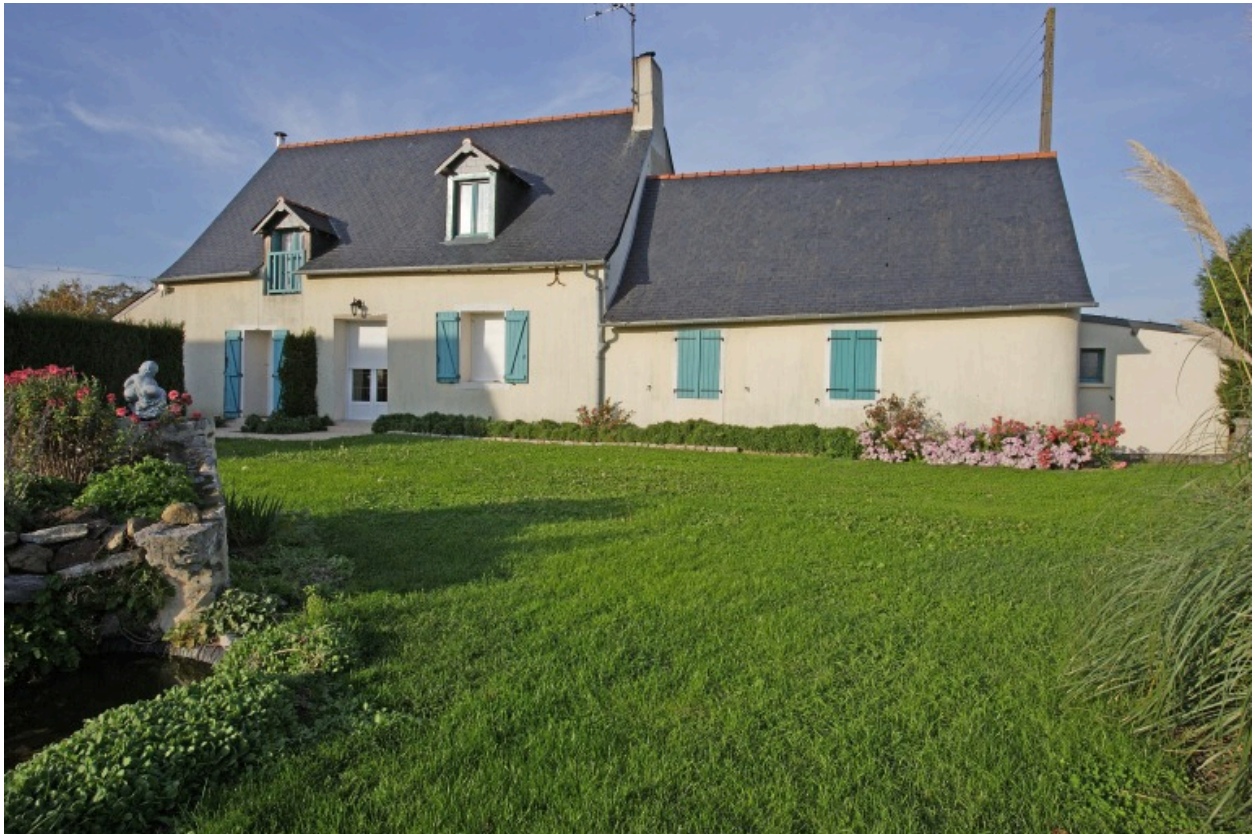
Le logis vu depuis le sud.
