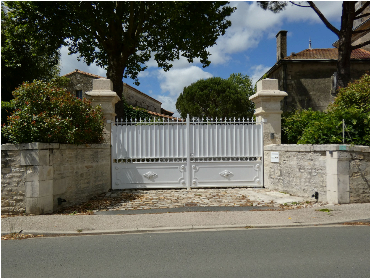
Le portail vu depuis le sud.
