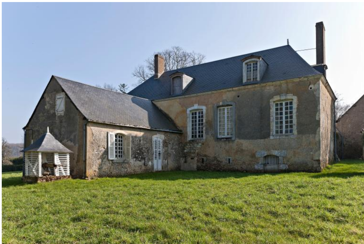
Aile et maison, depuis le nord-ouest. Au 1er plan, le puits.
