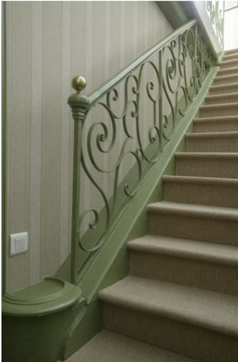
Première volée de l'escalier.
