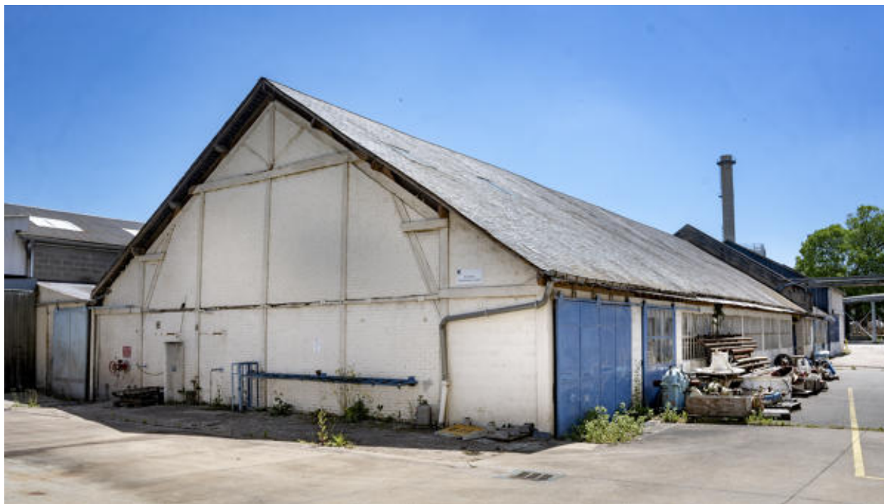
Atelier de réparation K de l'usine de papeterie.
