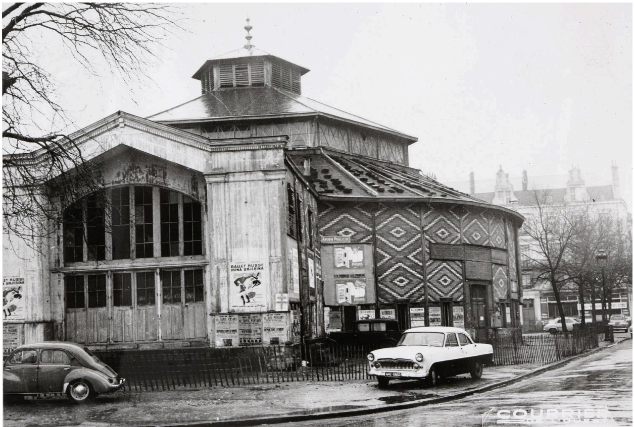
Vue d'ensemble avec la façade d'entrée, depuis le sud, fotogr., 1962.
