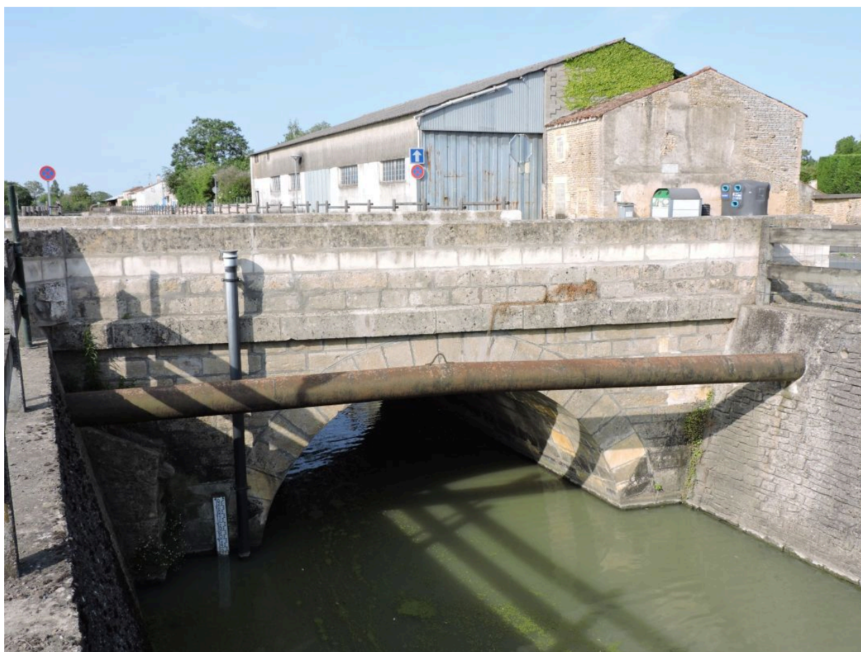
Le pont vu depuis l'est, côté amont.
