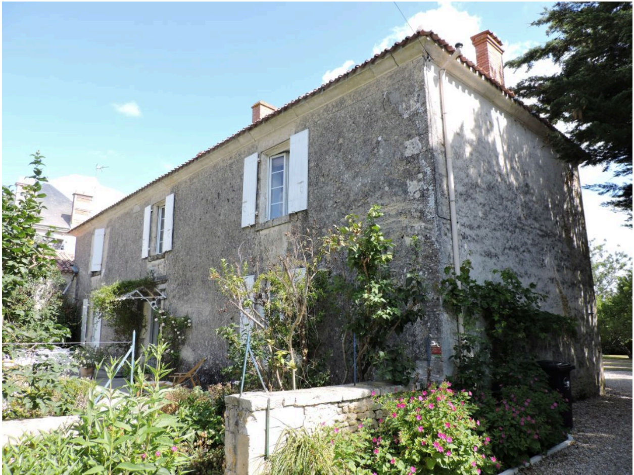
La maison construite en 1837 vue depuis le sud.
