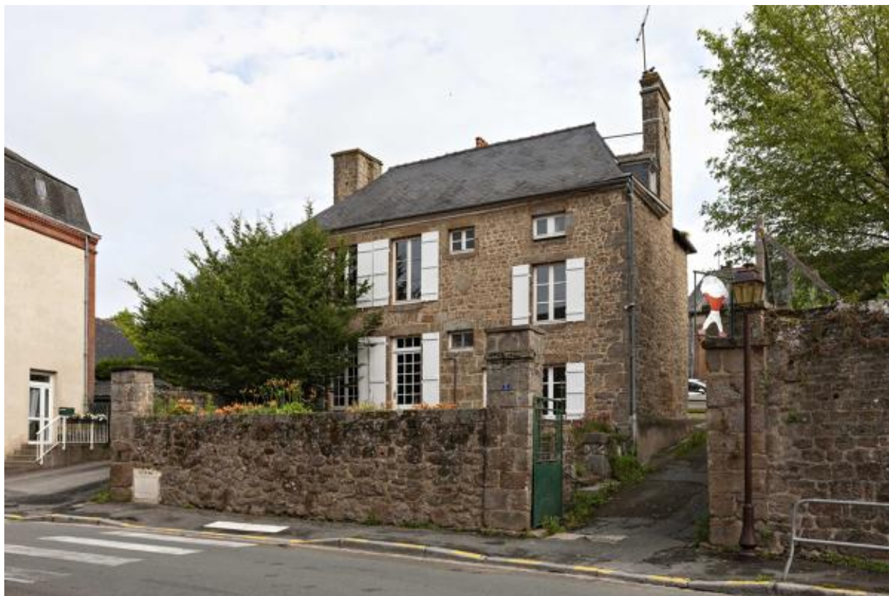
Façade principale du corps de logis avant.
