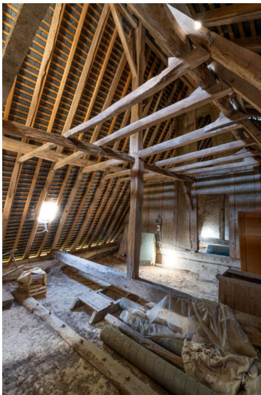
Ferme ouest : charpente du logis.
