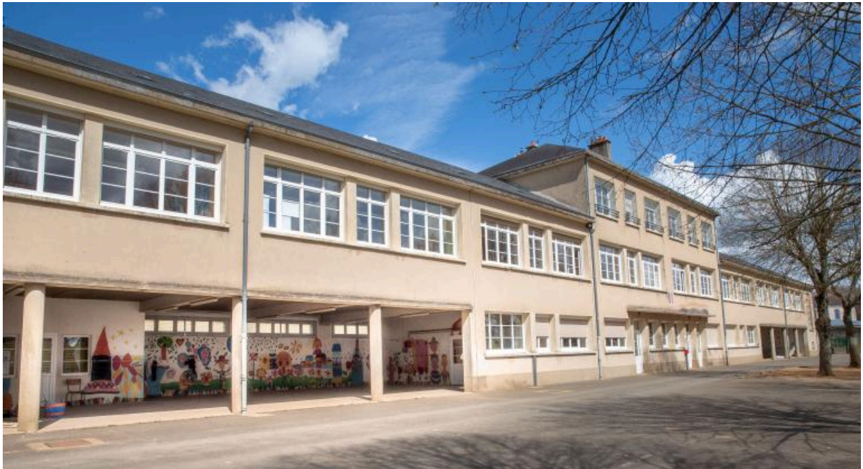
La façade sur cour de l'école primaire.
