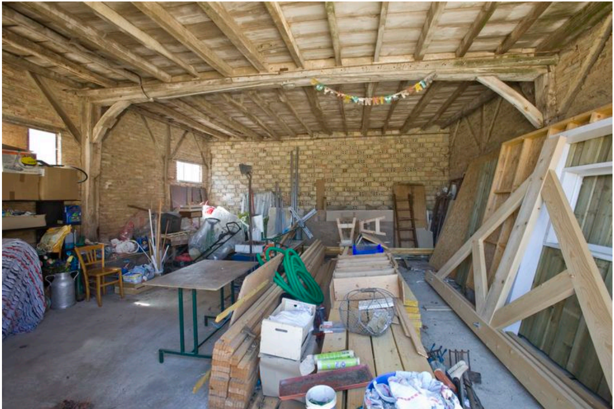
Remise : vue intérieure.
