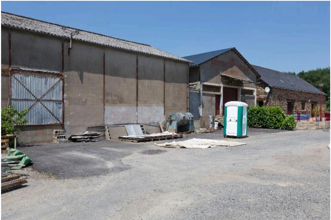
Entrepôt de la coopérative agricole construit en 1936, côté voie.
