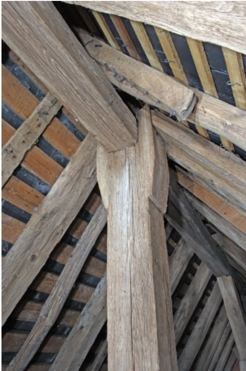
La charpente : vue de détail. La partie supérieure de la ferme principale marquée II.
