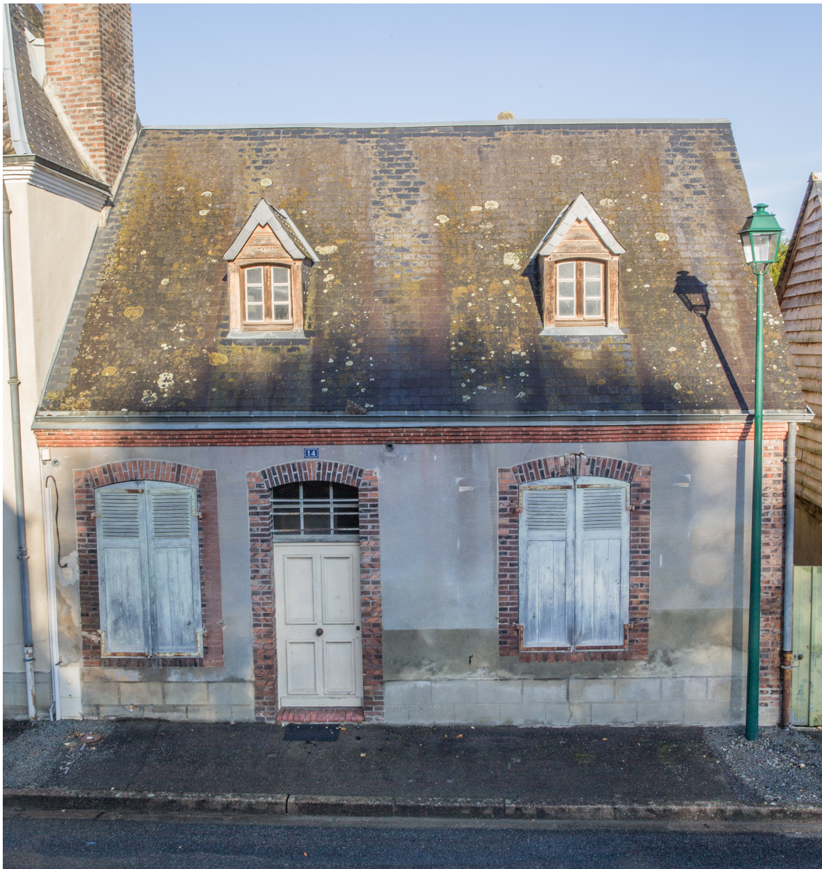
Une maison du XIXe siècle, rue de l'Eglise.
