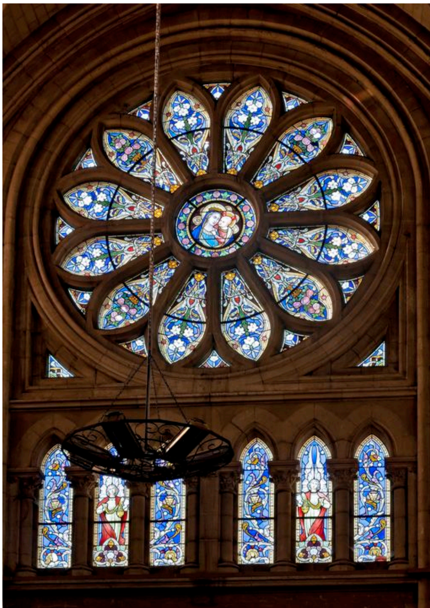
Vue d'ensemble des verrières 212, 106 et 108.
