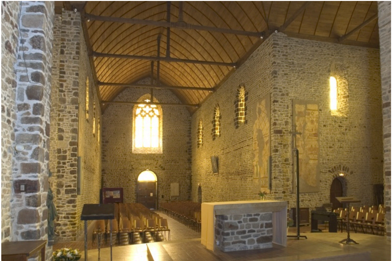
Vue de situation de deux panneaux.
