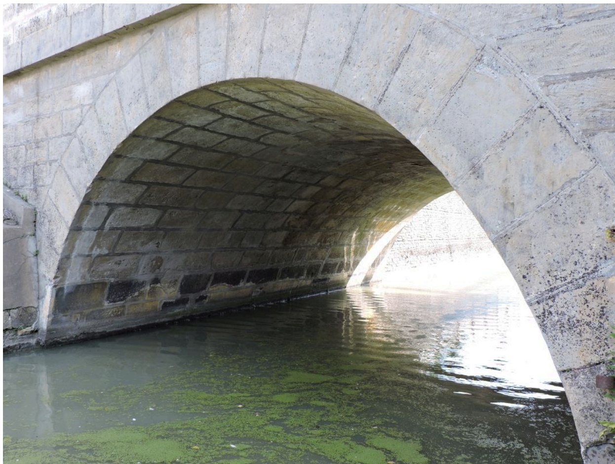
L'arche du pont vue côté aval, au sud.
