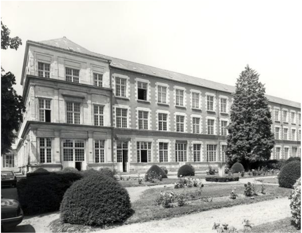
Anciens ateliers d'ajustage et de menuiserie (par Isabelle, Ch.-E.) : façade est, sur la cour des ateliers.
