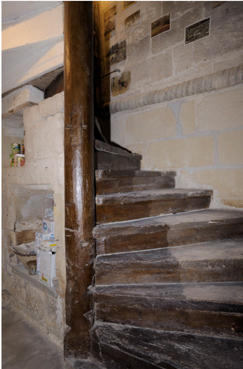
Escalier autrefois hors-oeuvre, en vis et en charpente (seconde moitié du XVIe siècle). Noyau orné de congés à la base.
