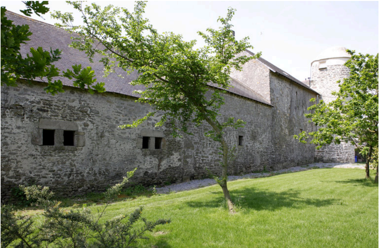
Vue de trois-quarts depuis le nord-est.
