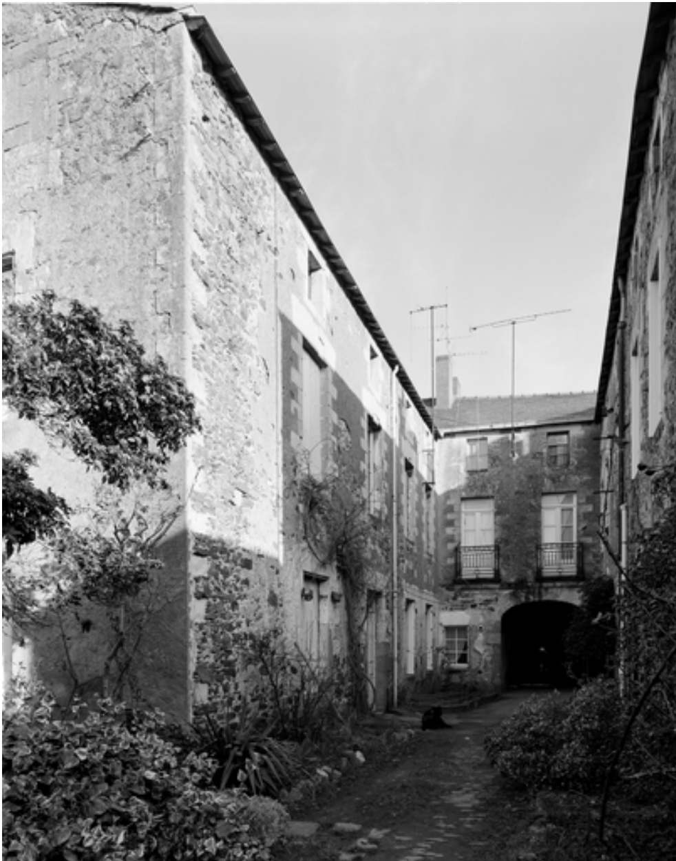
Vue d'ensemble depuis la cour vers le corps secondaire situé à l'ouest (1998).
