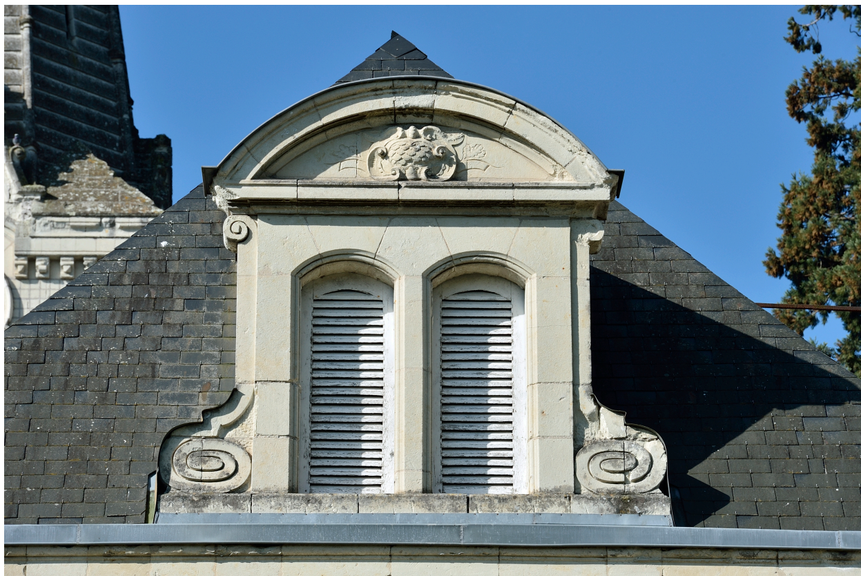
Bâtiments annexes. Détails d'une lucarne.
