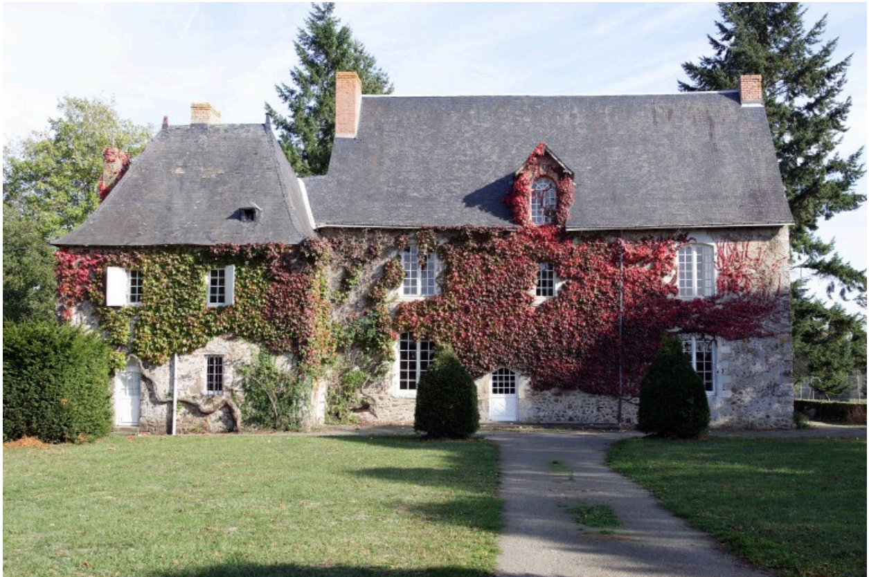
La façade antérieure vue depuis l'ouest.
