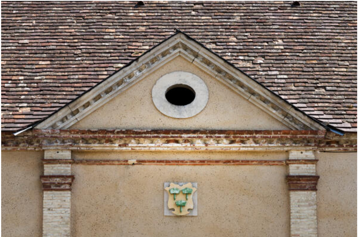
Vue de la partie supérieure de la travée centrale.
