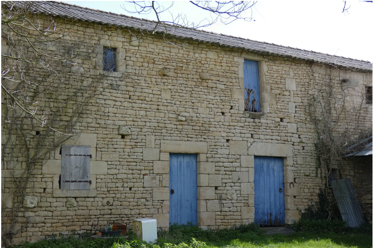
L'élévation ouest de la l'aile est, côté cour.
