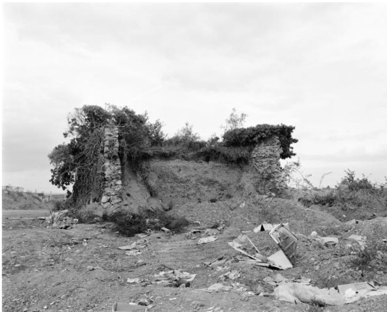
Vestiges de la rampe latérale est, vue en coupe depuis l'ouest, four à chaux du Lièvre, Montjean-sur-Loire.
