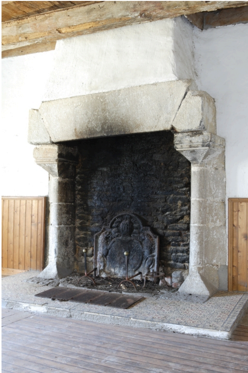
Aile ouest. Salle haute. Vue de la cheminée.
