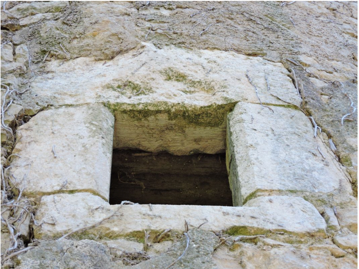
Petite baie à encadrement chanfreiné au nord du moulin.
