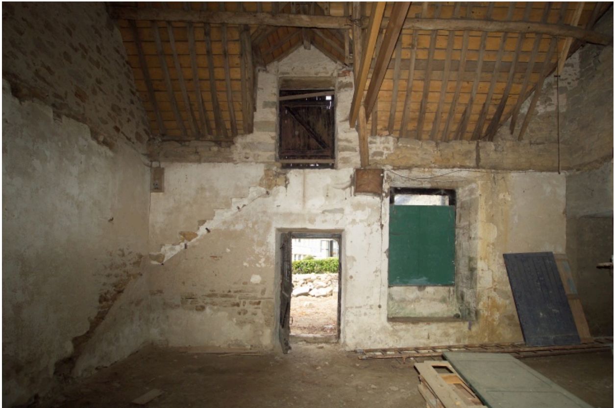
Bâtiment sud, intérieur vu vers le Nord.
