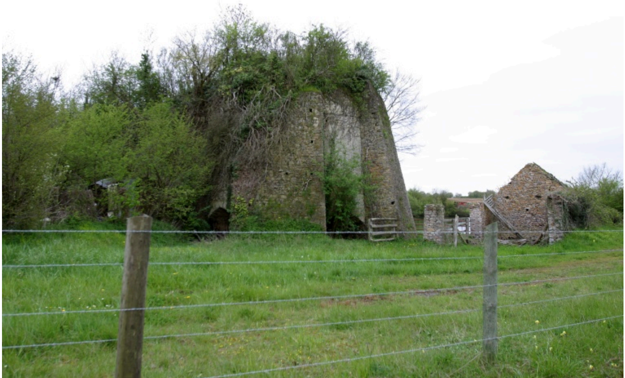
Le four et le hangar vus depuis le nord-est.
