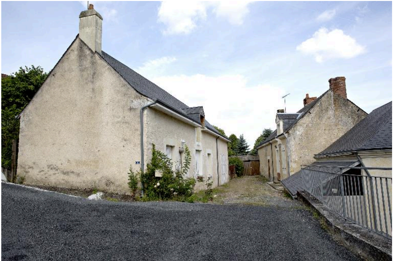
2, rue de l'église. Au fond à droite : 7-9, rue du Tusson (façade postérieure).
