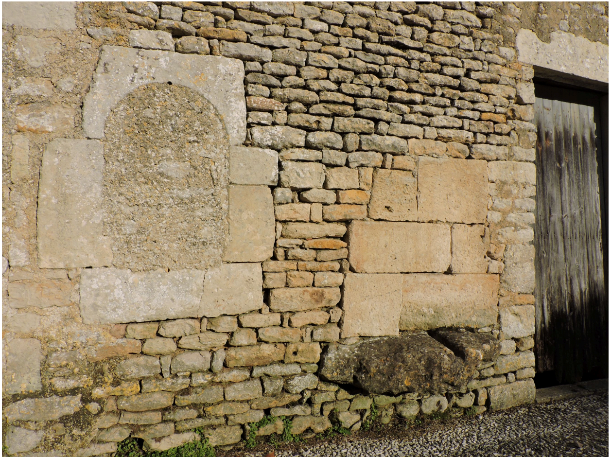
La baie en arc en plein cintre murée et la pierre d'évier.
